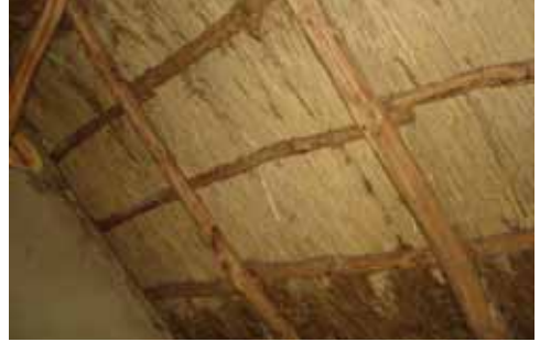
Das Reet wird an den Dachstuhl „genäht“
