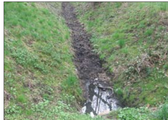
Total verschlammmt – hier kann kein Wasser abgeleitet werden
