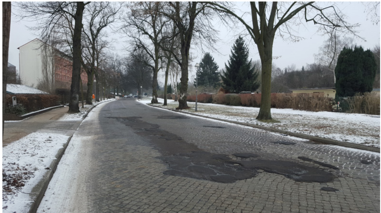
Risse im Bettungsmaterial und die Zersetzung des Straßenbelags sollen hier bald der Vergangenheit angehören.
