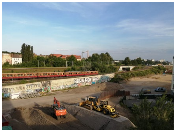
Baustelle der A100 an der Anschlussstelle am Treptower Park im Juli 2021.
